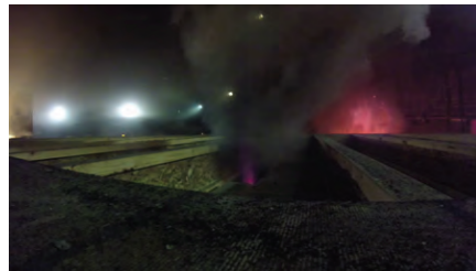
(d) Stud Bay Exhaust With Fan
