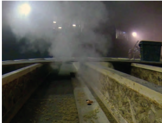
(b) Stud Bay Exhaust With Fan
